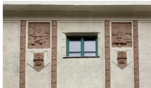
190-191. Részletek a homlokzatról
