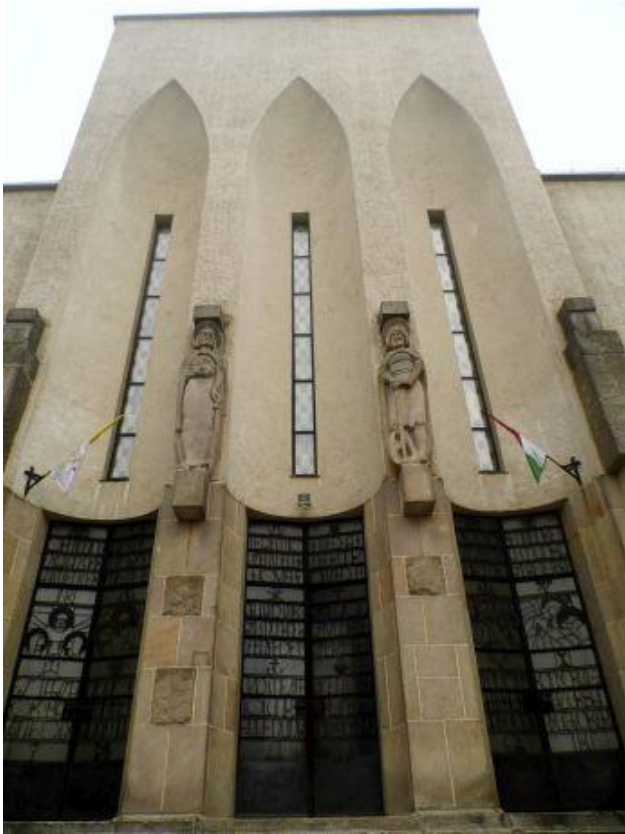
221. A remetékertvárosi Szentlélek-templom főhomlokzata a három portikuszfülkével.
