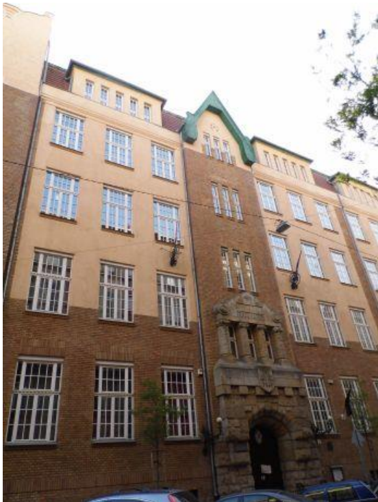
45. A Hernád utcai iskola homlokzata
