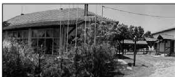
4. kép: Benkőbokor egykori iskolája a Nyíregyháza kertvárosi evangélikus egyház szeretetszolgálatára igényes kezelésében (saját fotó)
