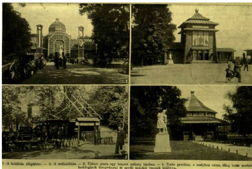
25. Kép Erdélyi hadikiállítás a Margitszigeten (Vasárnapi Ujság 1917. 38. szám, 607.p.)
