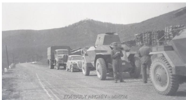
48. kép: A 39 M. Csaba első két, sorozatgyártott, lágyacél felépítményű, fegyverzet nélküli, csak kiképzésre használt példánya. A háttérben egy 39 M. Ford-Marmon-Herrington teherautó. 394
