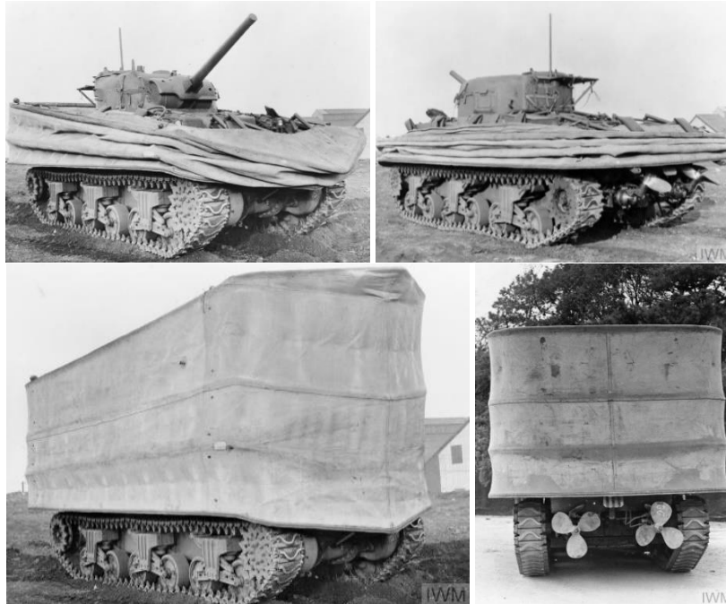
154. kép: A Sherman Duplex Drive leeresztett és felhúzott ponyvával. 951
