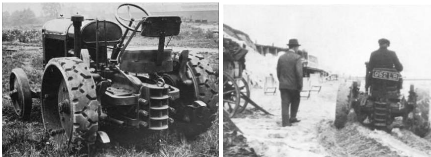
4. kép: A „karmos kerék” egy bemutatója egy International Harvester traktor segítségével. 87
