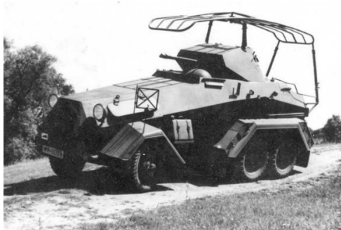
214. kép: A Büssing teherautó alvázra épült német Sd.Kfz. 232 (6-Rad) rádiós páncélgépkocsi. 1242 A Haris testvérek hasonlóságot véltek felfedezni eközött, és az állítólagos Hunor között.
