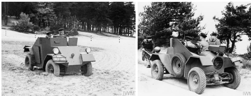
34. kép: Az Alvis Dingo. A jobb oldali képen hiányzik a páncélgépkocsi hátuljának burkolata, így látható a Straussler munkáira emlékeztető hátsó felfüggesztés. 303
