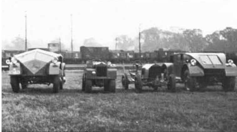
13. kép: Straussler korai kísérleti járművei valamikor 1935 tavaszán. A járművek balról jobbra: az AC-2 páncélgépkocsi prtotípusa (még a csepeli Weiss Manfréd által gyártott ideiglenes karosszériával), a Mountain Tractor vontató, a Scout Car és az AC-1 páncélgépkocsi prototípus. 147
