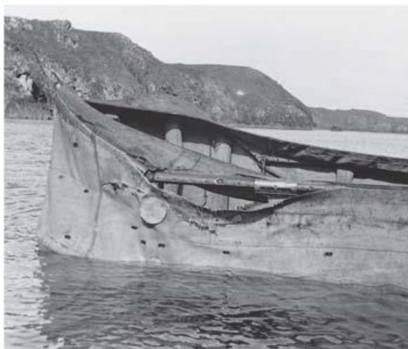
146. kép: A megerősített Straussler-szerkezet még megrongálódva is lehetővé tette az úszást. 925
