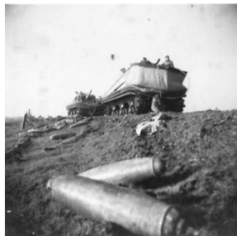
179. kép: Sherman DD harckocsik a rajnai átkelés után. Az előtérben a földön a ponyva felemeléséhez elhasznált, feleslegessé vált, üres, sűrített levegős palackok. 1063
