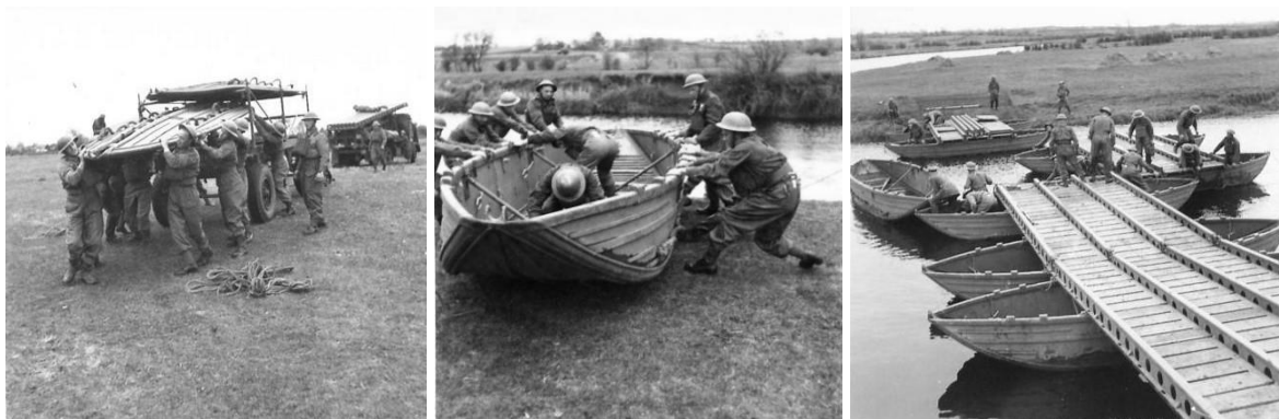
3. kép: Egy Straussler-féle összecukható csónakokon alapuló brit katonai pontonhíd összeszerelés közben, 1941-ben. 79
