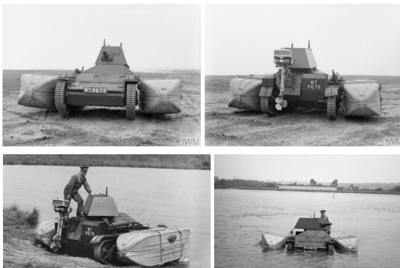
105. kép: Egy Light Tank Mk. IIA Straussler-féle pontonok segítségével úszik. 656
